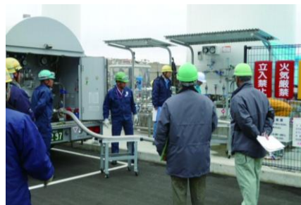
サテライト設備へのLNG荷卸作業
