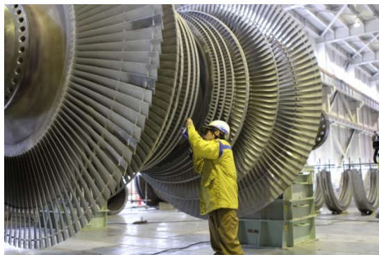
火力発電所定期点検工事
