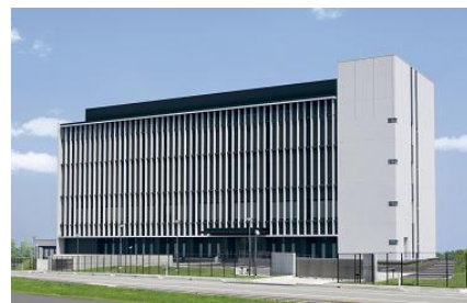
パワー・アンド・IT データセンター
