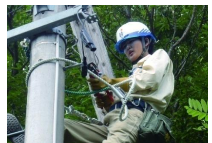
配電部門の女性従業員 (柱上での保守作業の様子)
