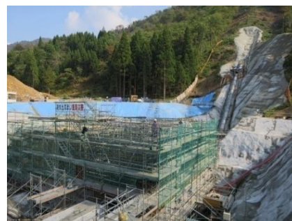
片貝別又発電所建設工事現場
