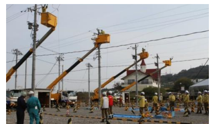
配電工事安全技能大会の様子
