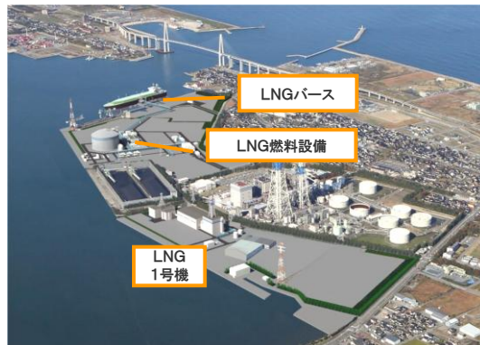
富山新港火力発電所LNG1号機イメージ図
