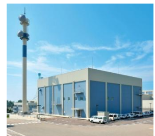
緊急時対策棟の設置
