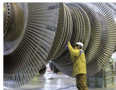
火力発電所定期点検工事の様子
