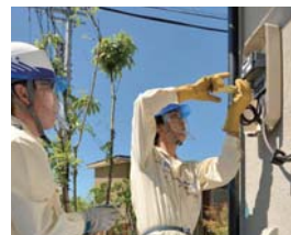
スマートメーター設置の様子
