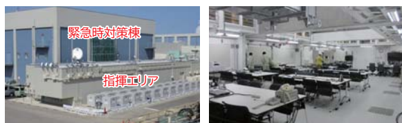
〔増築した指揮エリアの外観〕
