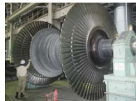
火力発電所定期点検の様子
