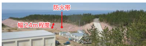
〔防火帯の設置状況〕
