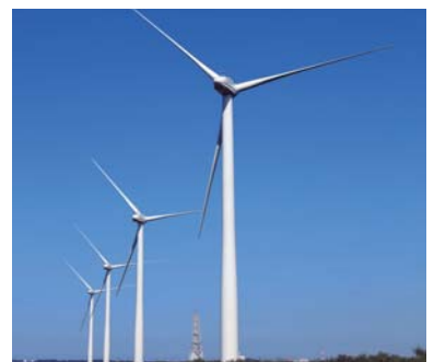
運転開始した三国風力発電所
