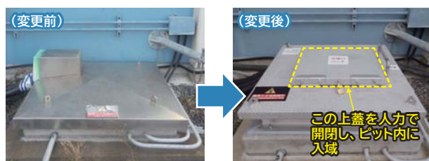
トレンチ上蓋の改造
