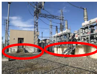
建物および開閉装置の高上げ
