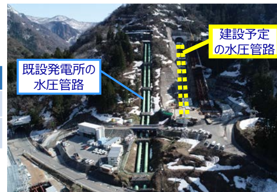
新姫川第六発電所の建設状況 (2021年3月、新潟県糸魚川市)
