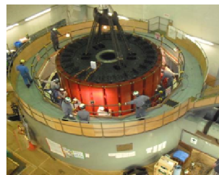
水車発電機のオーバーホール
