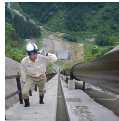
片貝別又発電所の水圧鉄管日常点検の様子
