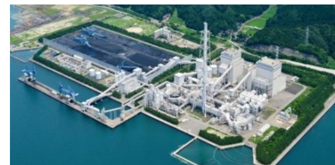
七尾大田火力発電所(バイオマス混焼中の発電所)
