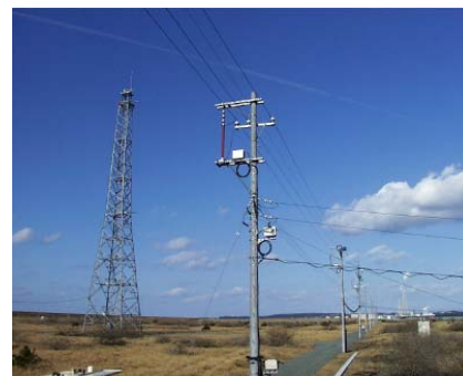
図2 三国試験センター (福井県坂井市)
