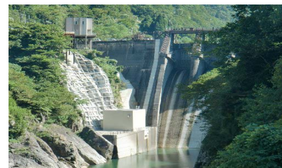
河川維持放流水を利用した 新猪谷ダム発電所 (2012年12月運転開始)
