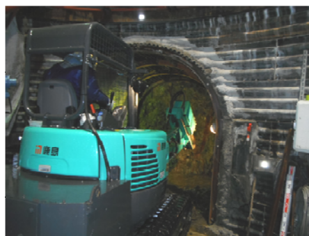
〔岩盤調査坑調査(横坑掘削状況)〕
