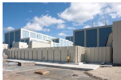
〔防潮壁(取水槽・放水槽廻り)〕
