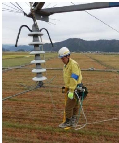
高所における懸垂装置用 素乗り作業足場の開発 (特許出願中)
