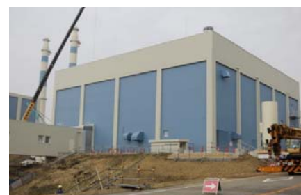
〔建設中の緊急時対策棟〕
