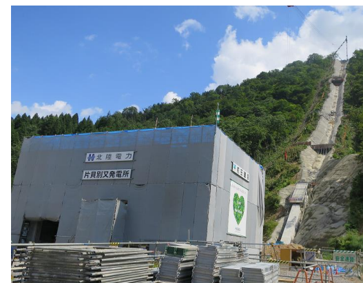
片貝別又発電所建設工事現場
