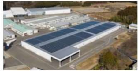
福井鎮蝶様さまに導入された太陽光パネル
