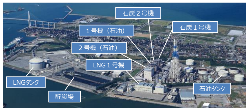
国内でも珍しい3種類の燃料（石油、石炭、LNG）を扱う富山新港火力発電所
