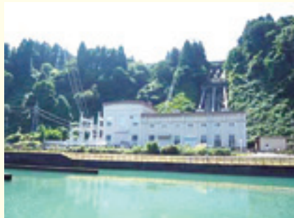
①上滝発電所
