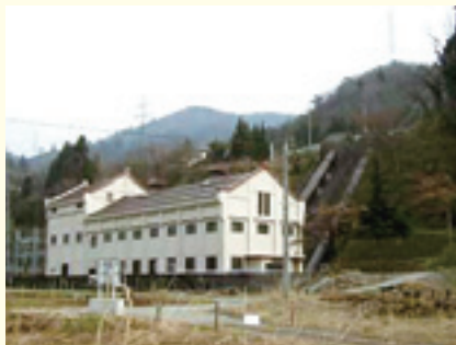
②松ノ木発電所
