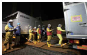
夜間での電源車による給電訓練
