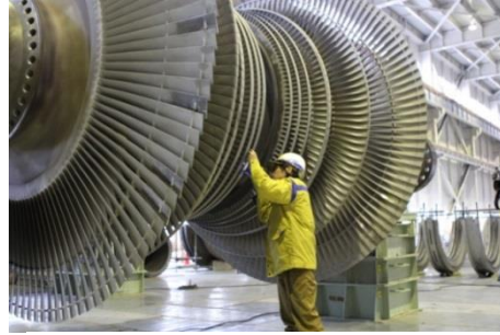
火力発電所定期点検工事の様子
