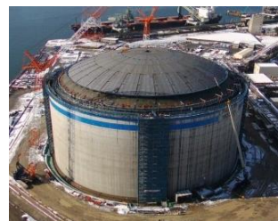
全景を現したLNGタンク(2017年1月末時点)
