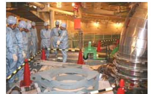
【耐震裕度向上工事】
