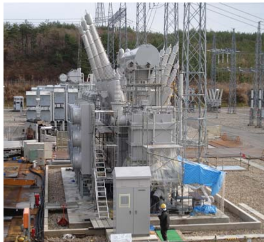
中能登変電所増設工事
