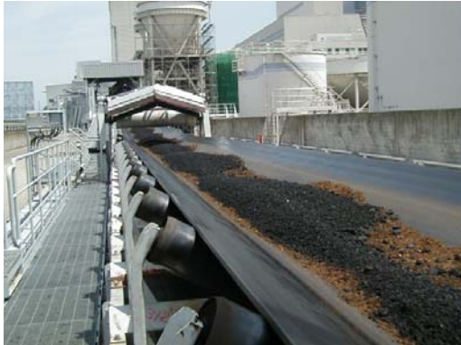
木質バイオマス混焼燃料搬送状況 (石炭+木質バイオマス)
