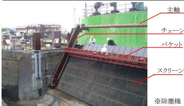
除塵機の取替作業
