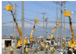
配電工事安全技能大会
