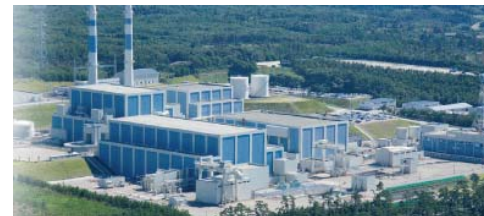
志賀原子力発電所
