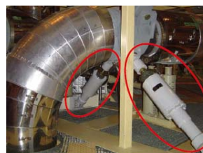
1号機主蒸気配管への防振器の追加
