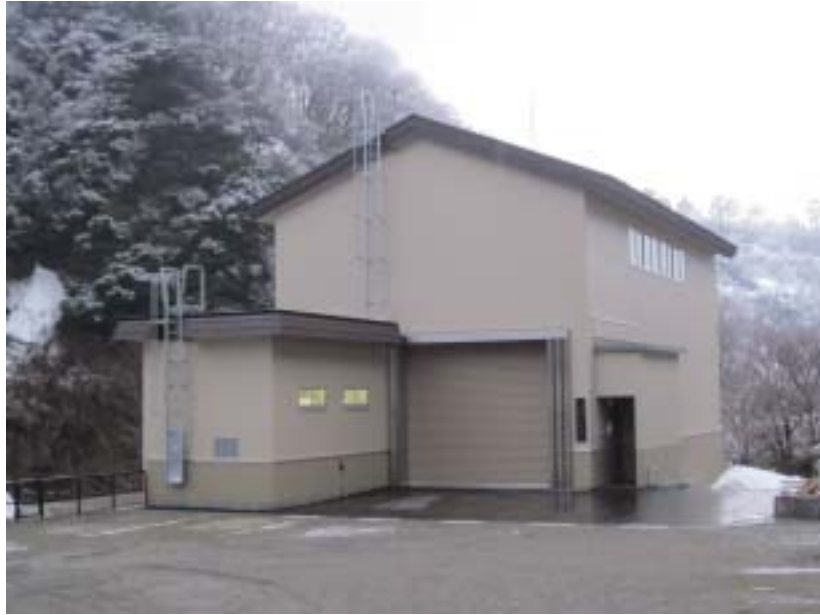
改修後の発電機
