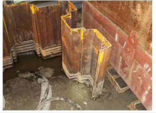
土留め用鋼矢板
