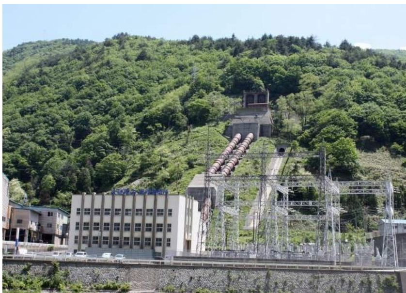
東町発電所 全景
