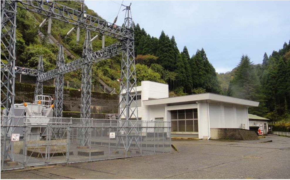
大日川第二発電所 本館
