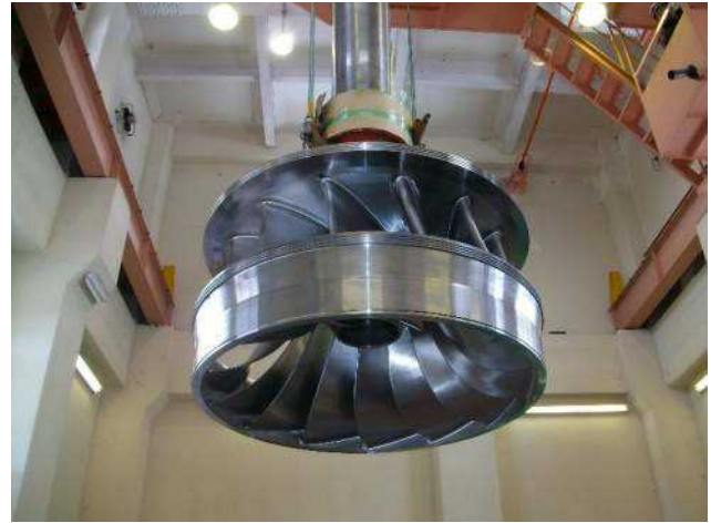
真名川発電所 水車ランナ
