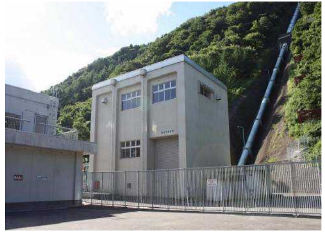
真名川発電所 本館
