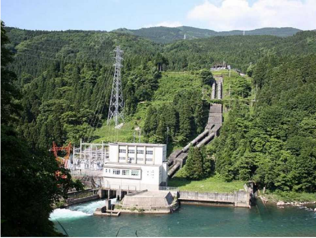
猪谷発電所 本館
