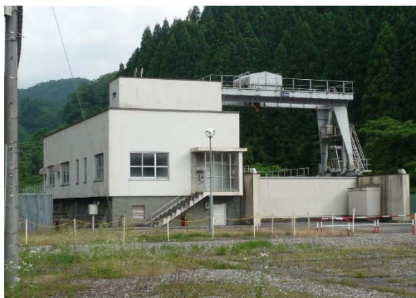
小俣発電所 本館
