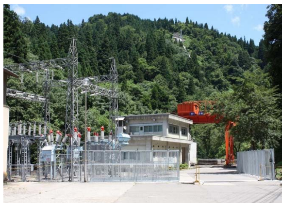
滝波川第一発電所 本館
