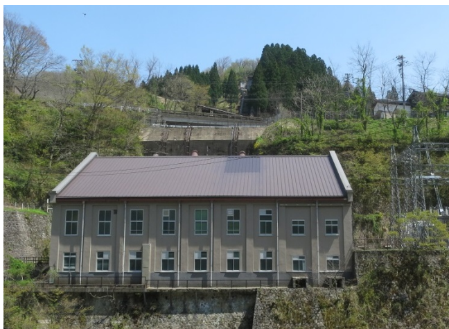
吉野谷発電所 全景
