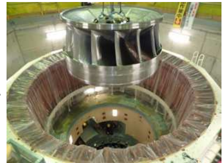
手取川第二発電所のランナ取替状況（2020年2月）
