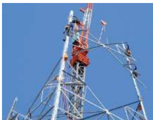
鉄塔組立工事
