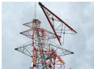
大型クレーンを用いた鉄塔組立工事
