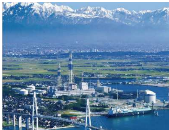
[富山新港火力発電所]
