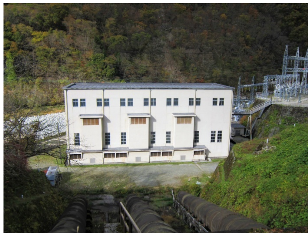
牧発電所 全景
