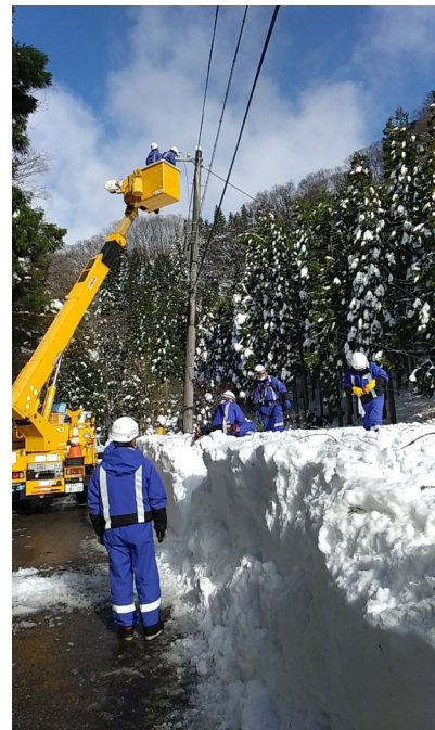
停電復旧作業
