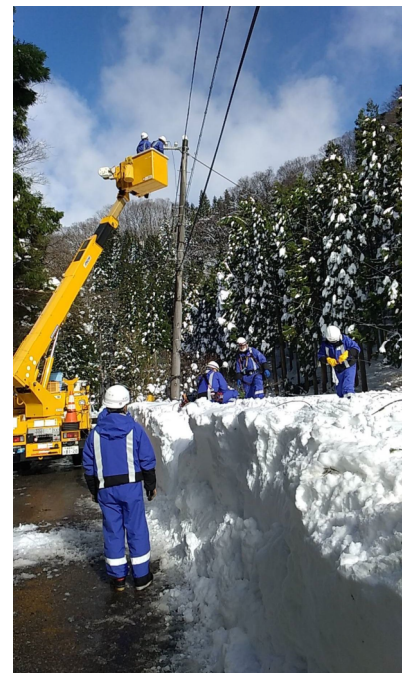
停電復旧作業
