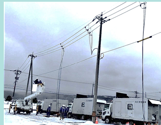
配電線への高圧発電機車接続
