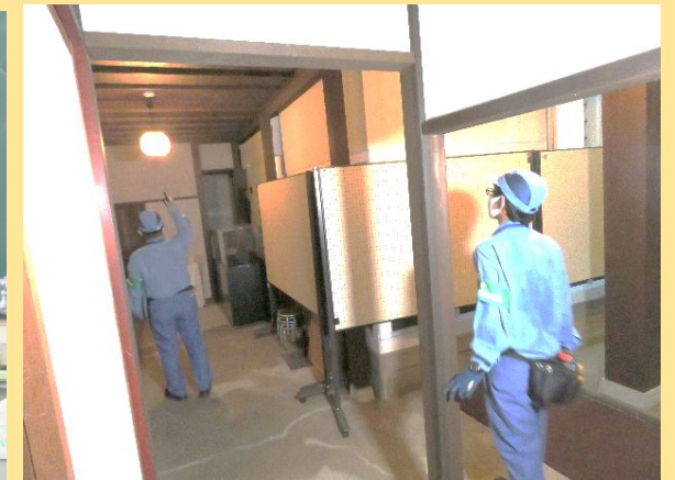
文化財の電気設備点検
