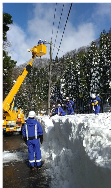
停電復旧作業
