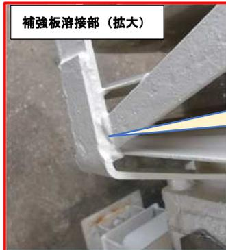
補強板を重ねた溶接構造
