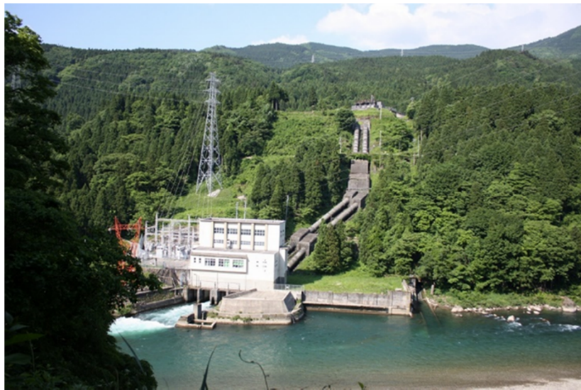
猪谷発電所 全景
