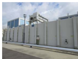
防潮壁の設置
