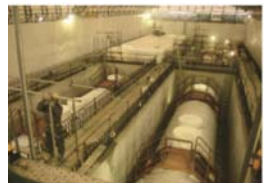
地下式軽油タンクの設置
