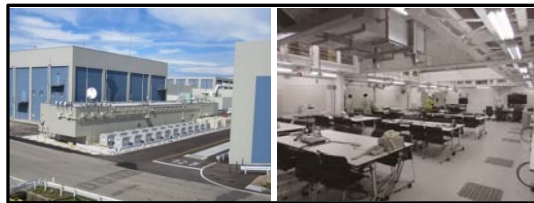
増築した指揮エリアの外観 (増設緊急時対策所) 指揮エリア内部の様子
