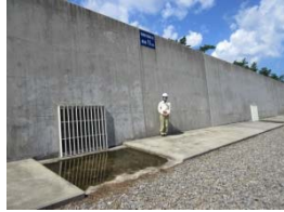
防潮堤の設置
