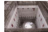
本体装置の据付
