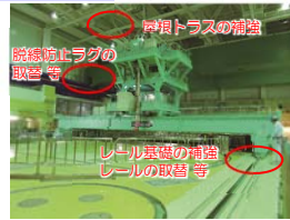
耐震安全性向上工事
