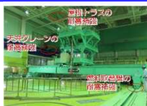
耐震安全性向上工事
