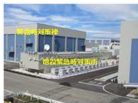
増設緊急時対策所 (外観)
