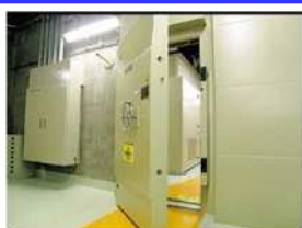
水密扉の設置
