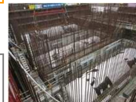
地下式軽油タンクの設置 (2017年1月)
