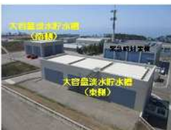
大容量淡水貯水槽の設置
