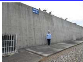
防潮堤の設置
