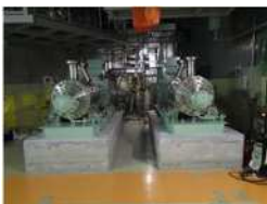
常設代替低圧ポンプの設置
